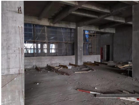
急外楼四层介入手术室 2 拟建区域现状
