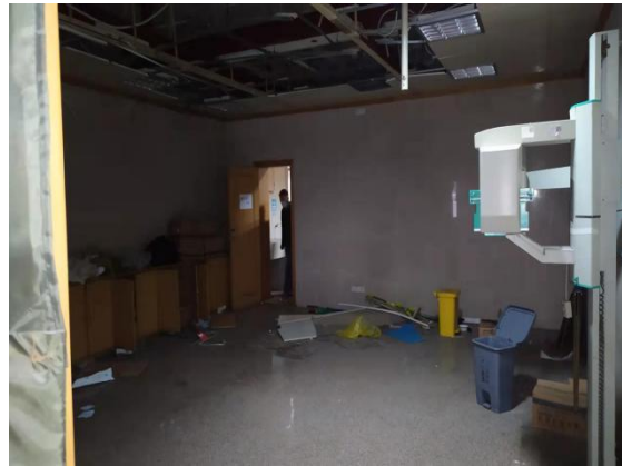
老内科楼二层 DSA 手术室 2 拟改建区域现状
