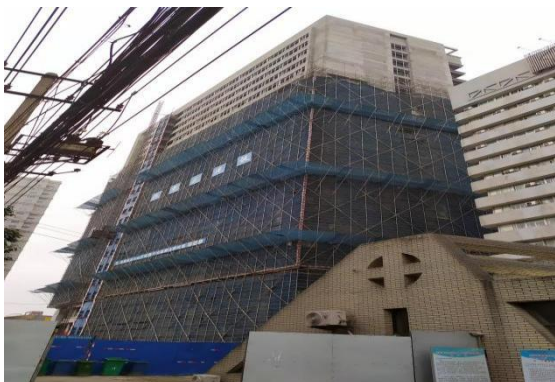
蚌埠市第三人民医院急外楼
