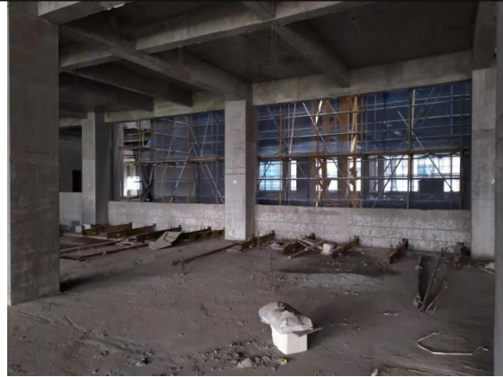
急外楼四层介入手术室 1 拟建区域现状
