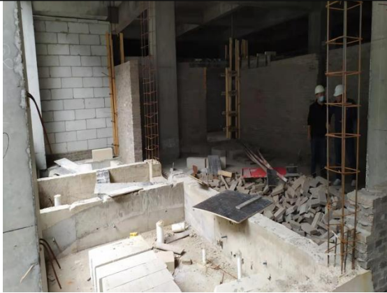
急外楼一层急救介入手术室拟建区域现状
