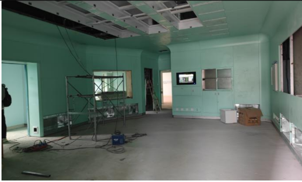
急外楼四层手术部介入手术室拟建区域现状
